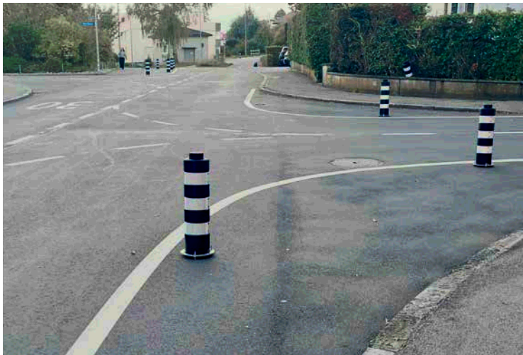
Zahlreiche Poller und Verengungen der Fahrbahn an der Kreuzung Beethoven-/Füllerichstrasse
